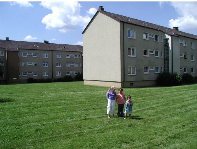
Mehrfamilienhäuser am Köhlerweg Zwischen den Häusern ist "Spielen verboten". Konflikte zwischen Alt und Jung sind in Emst eher normal, denn der Anteil an Menschen über 60 ist hier höher als in keinem anderen Stadtteil Hagens. Hier muß für gegenseitiges Verständnis geworben werden.
