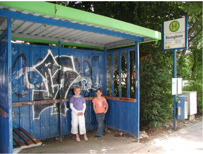
Bushaltestelle am Köhlerweg Hier werden unsere Kinder schon früh mit Aggression und Brutalität konfrontiert. Resignation vor dem vermeintlich Unabwendbaren kann nicht die Lösung sein. Hier muß gegengesteuert werden und das Potential ist dafür ist da.
